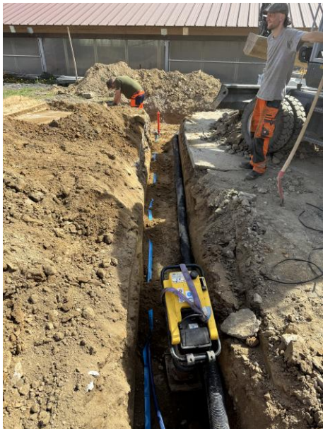
Kanalanschluss
