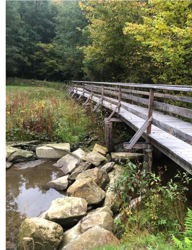
Erneuerung der Stege im Kurpark
