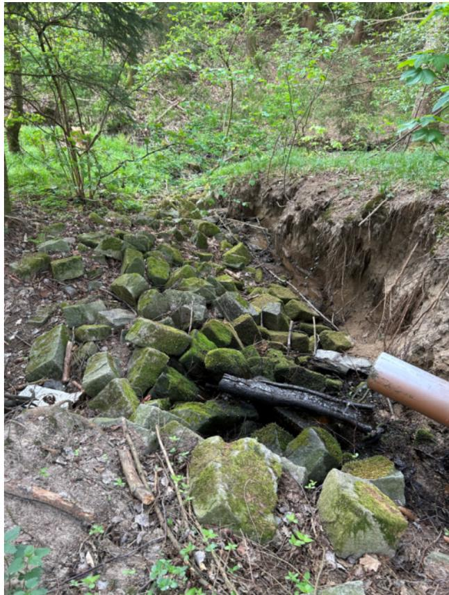
Abb. 4 – Auslauf Drosselabfluss zur Einleitungsstelle
