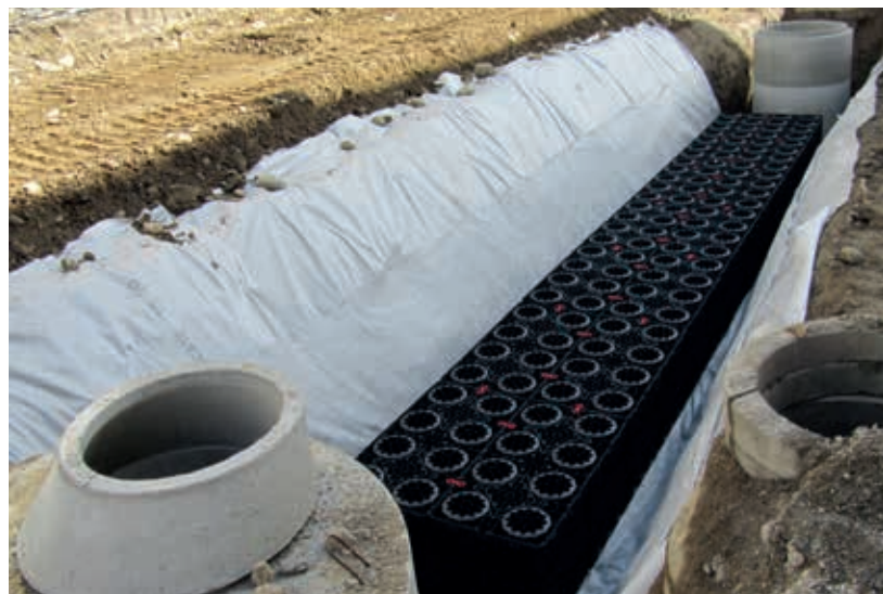
ACO Stormbrixx zur Regenwasserrückhaltung mit Q-Brake Wirbeldrossel von ACO zur Drosselsteuerung
