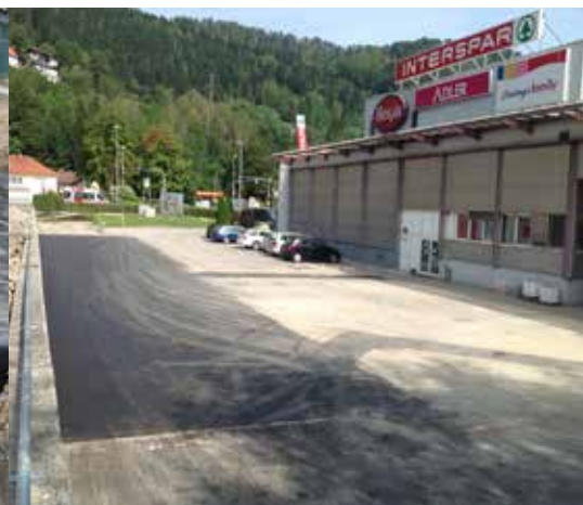
Fertiger Einbau der Versickerungsrigole der Dachflächen NORD/SÜD
