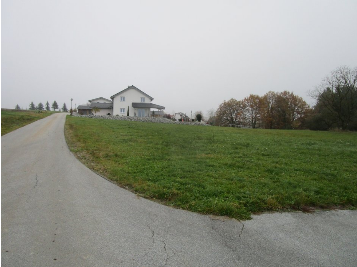
Abbildung 8: Überblick über die geplante Baufläche (von der Nordwestecke des Geltungsbeereiches, Blickrichtung nach Osten)
